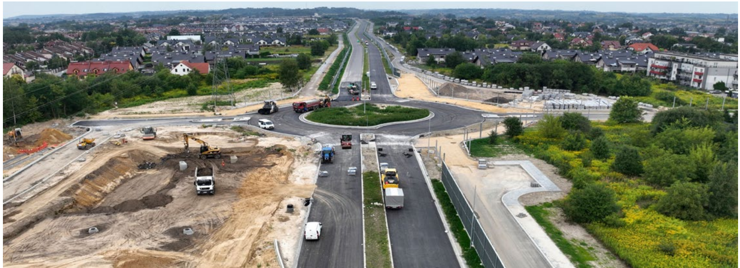
Fot. Widok na budowaną Zachodnią Obwodnicę Zielonek
