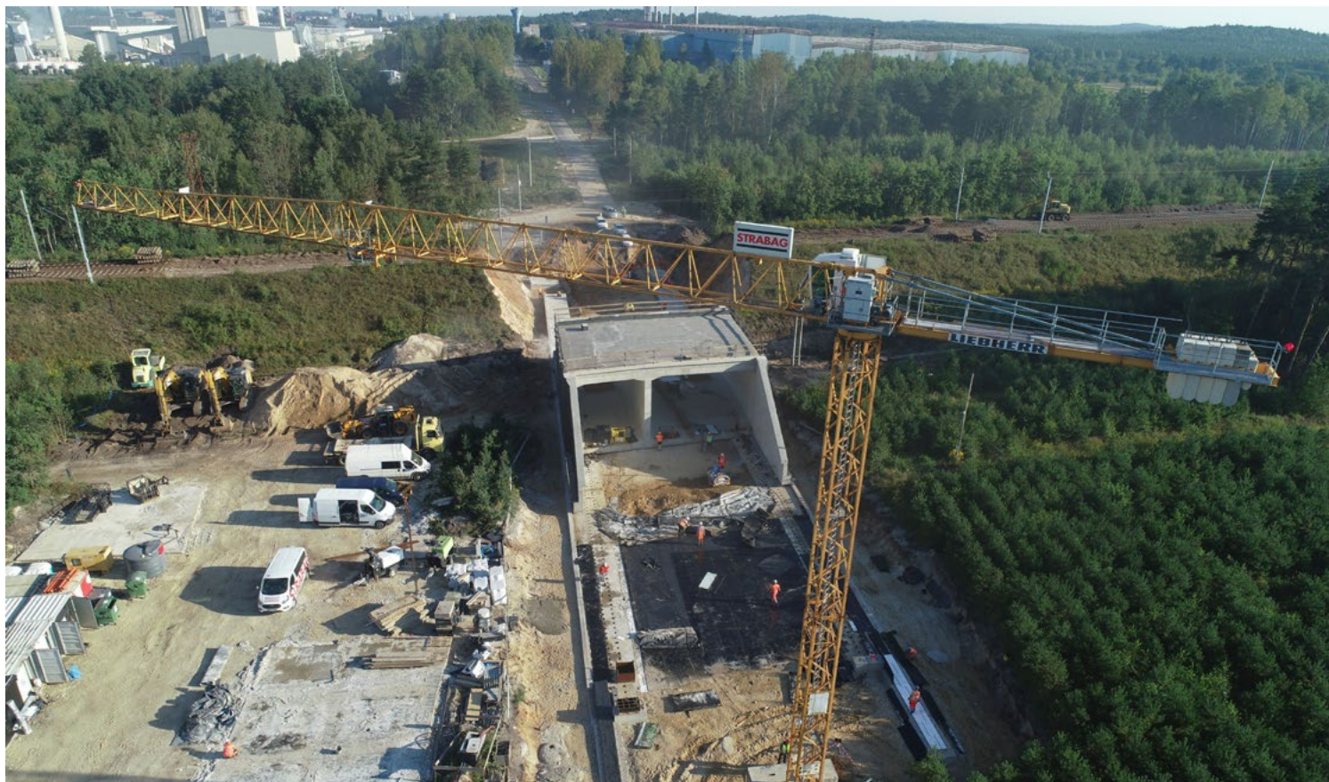
Fot. Konstrukcja wiaduktu w trakcie przemieszczania na miejsce docelowe w nasypie
