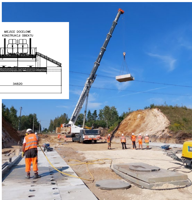
Fot. Stanowisko prefabrykacji (góra) oraz budowa torów ślizgowych pod konstrukcję wiaduktu (dół)
